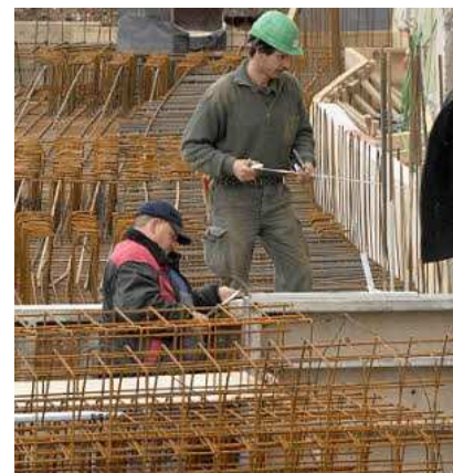
Arbeiter bringen die Bewehrungen für die Bodenplatte ein.
