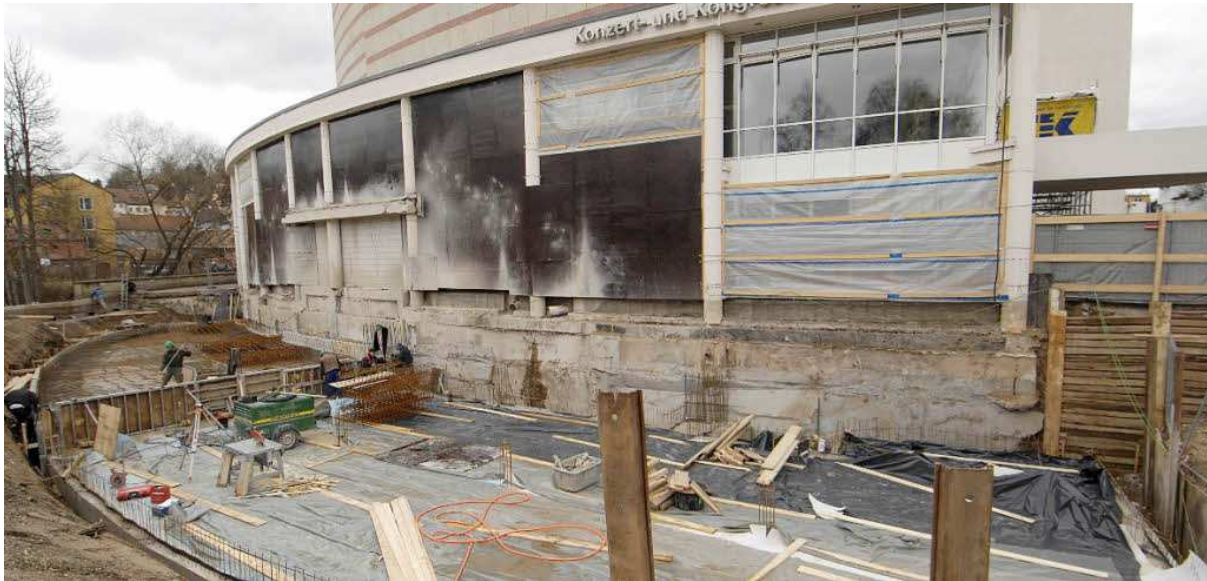
Die Baugrube vor der Konzerthalle wird nicht mehr lange sichtbar sein. Bis Ostern sollen die Kellerwände stehen. Fotos: Ronald Rinklef
